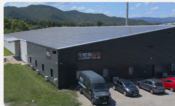
Notre plateforme YESSS Logistique à Saulce-sur-Rhône.
