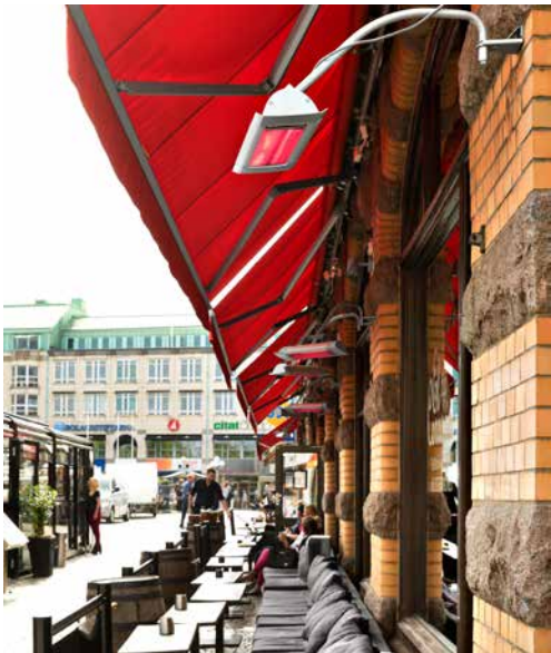
Grâce à sa console d'extension, l'émetteur peut être positionné plus bas que son point de montage.
