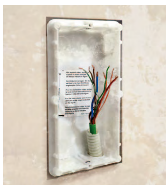
Remplacement de la platine de rue
