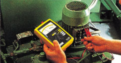
Contrôle de l'isolement des enroulements d'un moteur.
