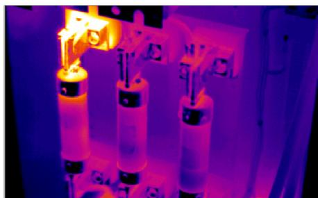
Contrôle d'armoires électriques
