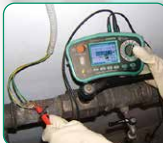
Continuity check of equipotential bonding
