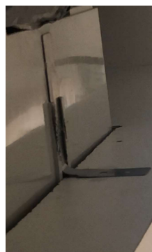
Enfoncer les clips pour fixation du plénum
