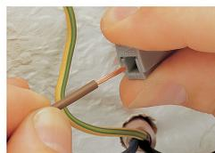
Raccordement du conducteur (côté luminaire) : serrer la borne et introduire le conducteur dans l'ouverture.
