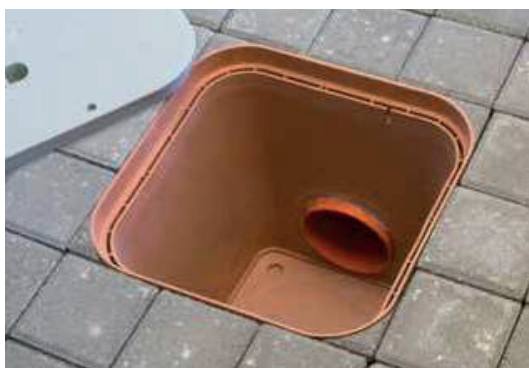
Installation avec tuyaux hydrauliques
